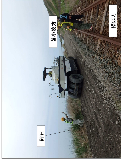
写真1 工事用通路の整備状況
