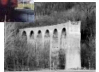
第一幾品川橋梁跡
