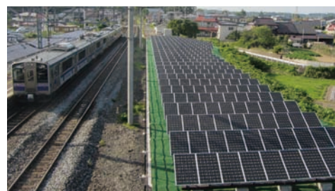
平泉駅に設置された太陽光発電パネル
