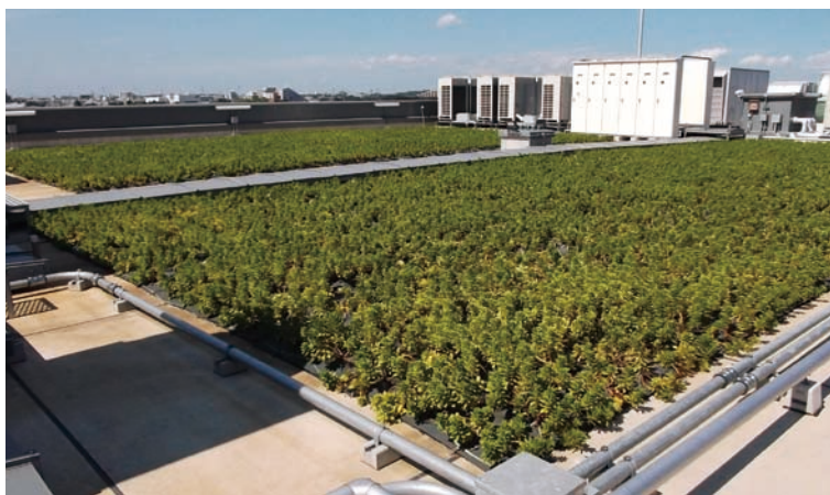
千葉支社ビルの屋上緑化
