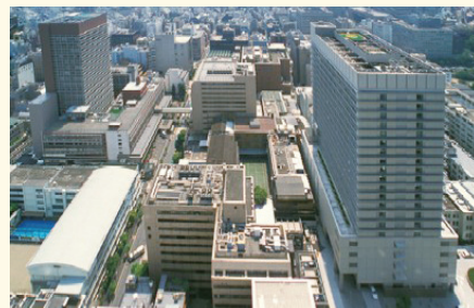
中央棟(右手前)と大学1号館(左奥)
