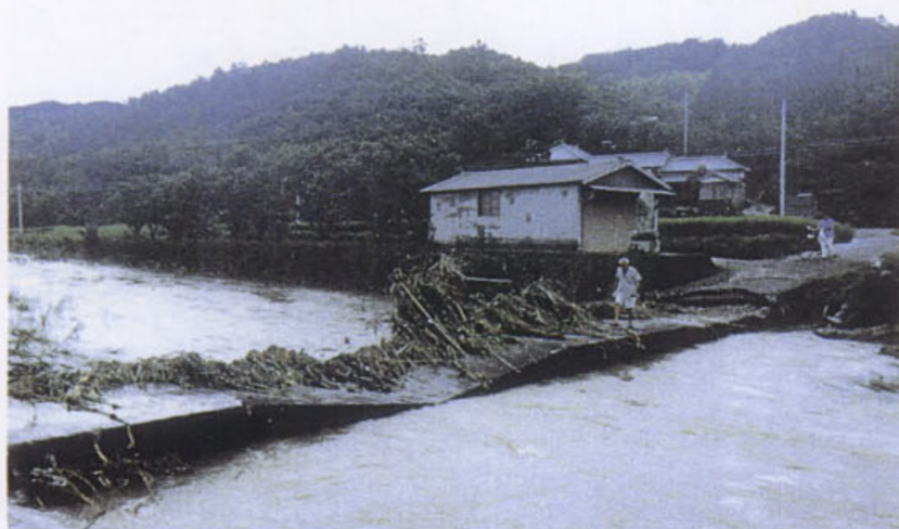
写真 11.1 潜水橋にゴミや草木がひっかかった事例
