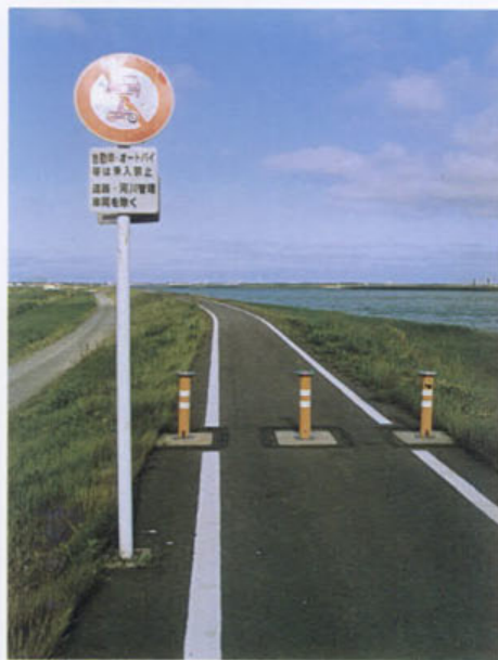
写真13.1 柵等、標識による規制の例
