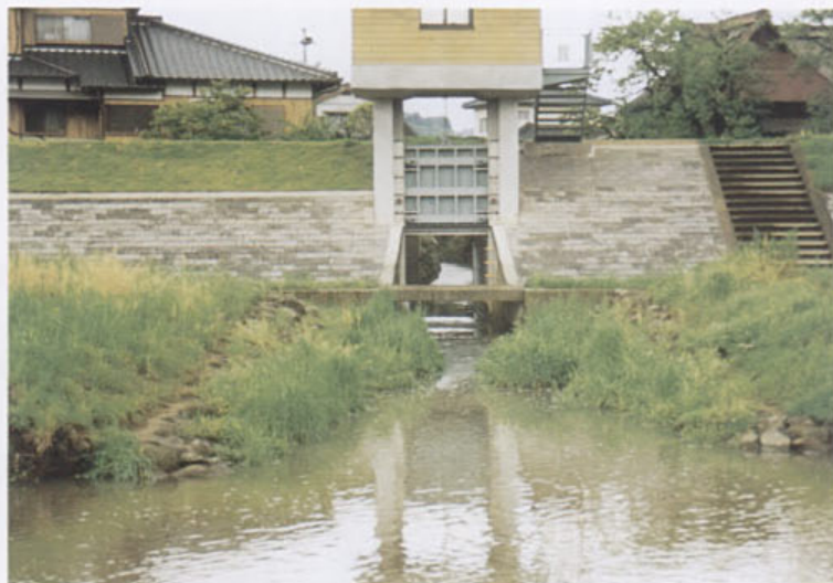
写真 3.1 段差による緩傾斜化を実施した事例
