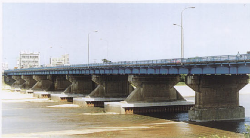
写真 10.1 露出した橋脚基礎の補強事例
