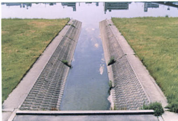
写真4.1 堤外水路の実例
