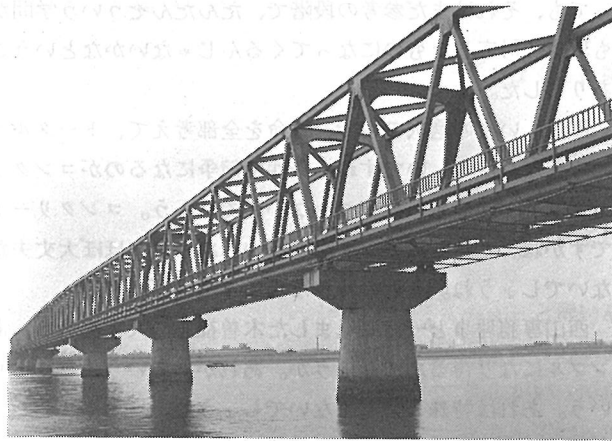
地下鉄東西線 荒川鉄橋
