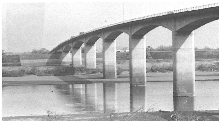
写真一4 埼玉大橋
