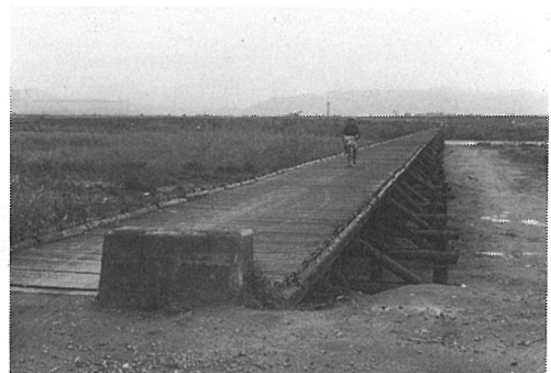
写真-3 上津屋橋
