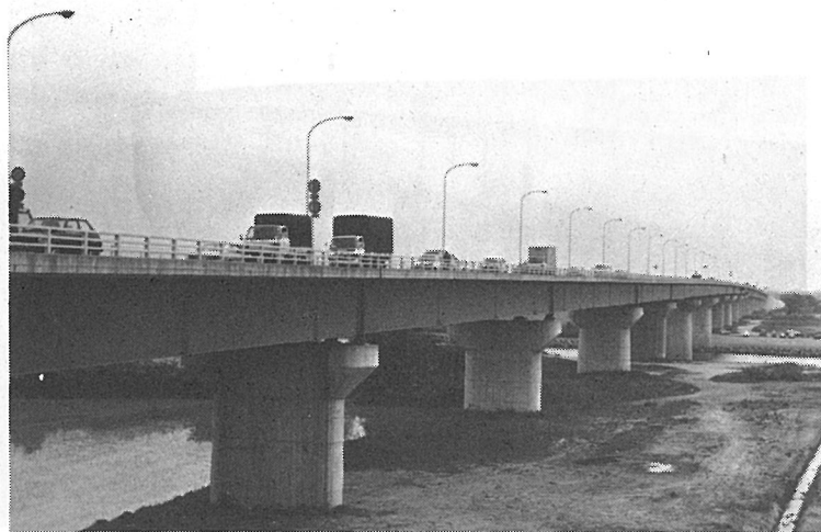
写真-14 秋ヶ瀬橋
