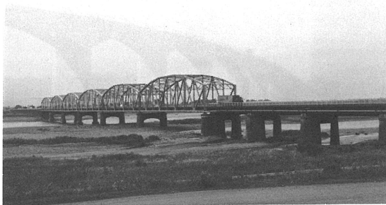
写真-3 坂東大橋
