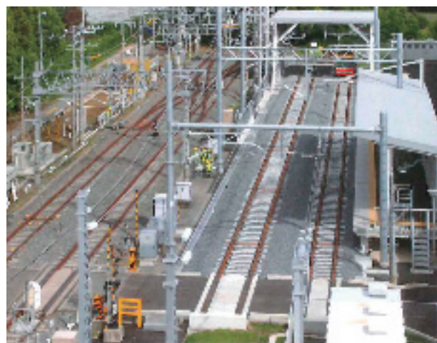
屋外実習設備
