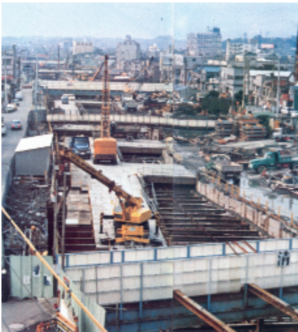
写真-6-1 河川内工事（長者町工区）
