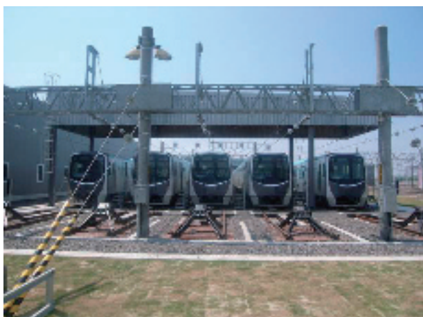
写真－1 仙台市地下鉄東西線荒井車両基地
