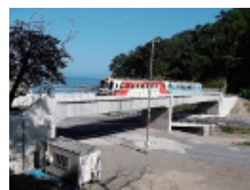
三陸鉄道北リアス線ハイペ沢橋梁
