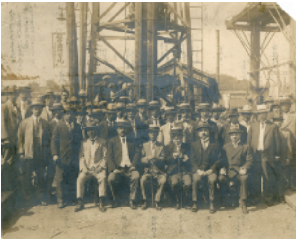
地下鉄トンネル工専用杭打機を背景にして早川徳次と関係者
