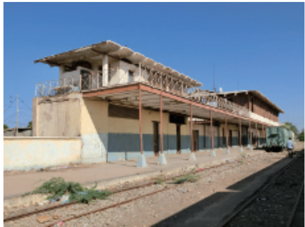
写真-17 ジブチ駅本屋（左側）と発着ホーム。かつてはここからエチオピアのアディス=アベバに向けて旅客列車が運行していた。現在は使用されていない駅本屋には人が住んでいる。(南東を見る。2015年4月21日)
