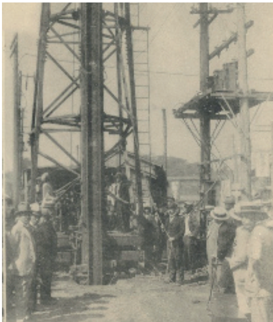
地下鉄トンネル工事用杭打機
