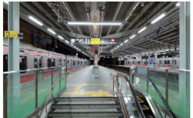
写真-1 ホーム照明（LED化後）
