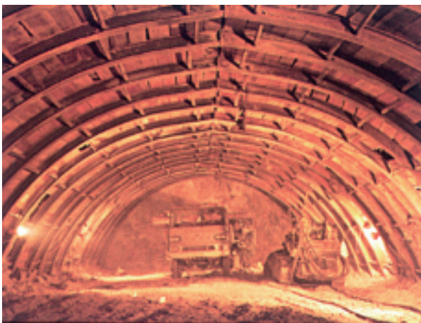
写真-7-3 山岳トンネル工法を使用した工事
