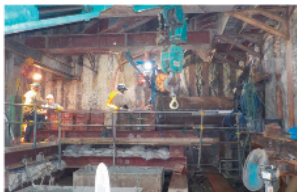
アンダーピニングに向けた準備が進む博多駅部
