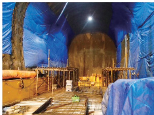
躯体構築中のナトム部
