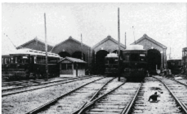
図1 開業当時の西代車庫
