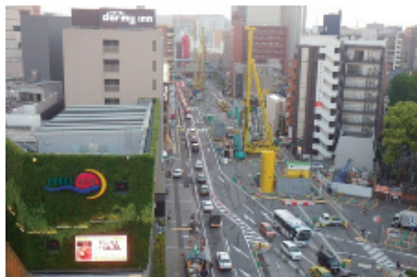
土留打設中の中間駅部
