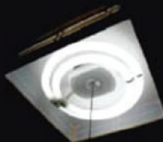
第3世代 蛍光灯 発光効率：75 lm/W
