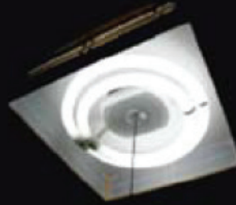
第3世代 蛍光灯 発光効率：75 lm/W
