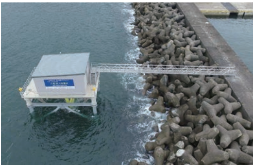
日本で初めて系統に連系した波力発電所 (2016年9月岩手県久慈市に設置) : 最大出力43 kW The Kuji Wave Power Plant (rated output 43 kW), Japan's first grid connected wave power generator
