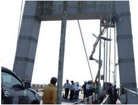
不具合のある吊橋のタワーの長期モニタリングのために傾斜計を設置（ヤンゴン市、ミャンマー） Installation of inclinometer for a long-term monitoring to the tower of a suspension bridge in Yangon, Myanmar
