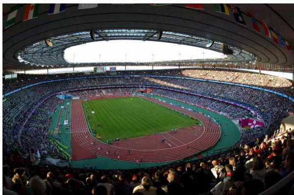
Stade de France - filled to capacity
