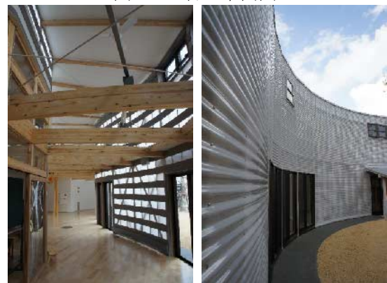
図 9 木造中空外壁（左：内側、右：外側）
