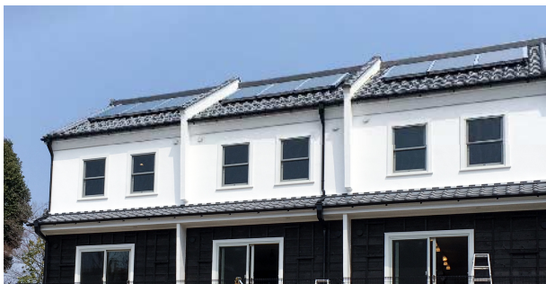
図5 集合住宅に設置された平板型集熱器
