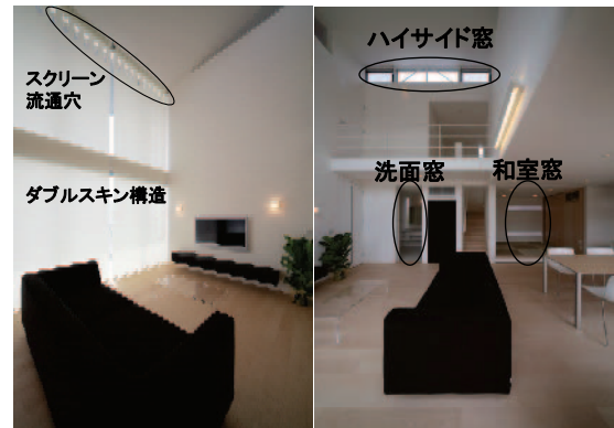
図3 穴あきロールスクリーンと北面の窓位置
