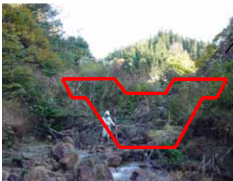
仙之沢川砂防堰堤
