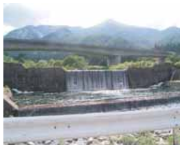
関越自動車道
