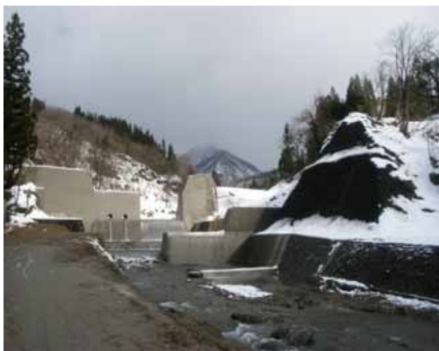
守門川下流砂防堰堤(施工中)
