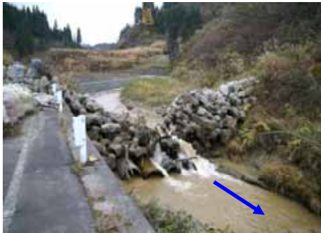
相川川溪流保全工
