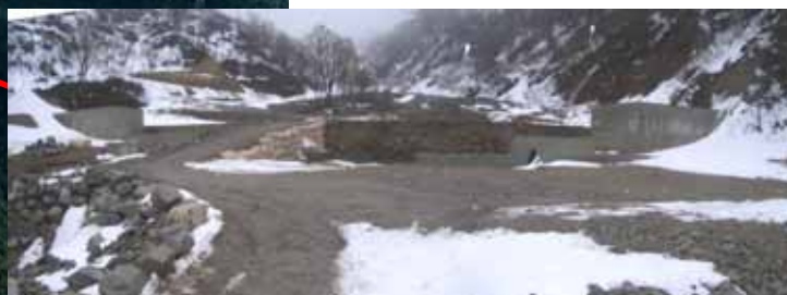
檜倉沢第1号砂防堰堤(施工中)
