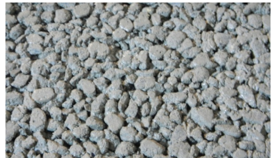
ポーラスコンクリート舗装の拡大写真
