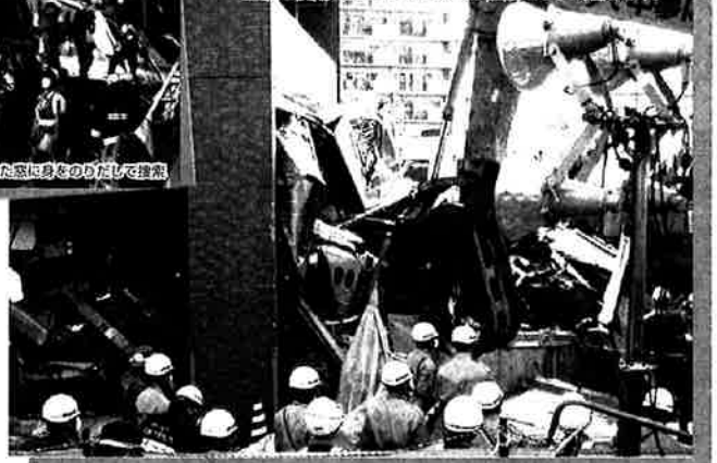
重機を使用しての作業も細心の注意をもって行われた
