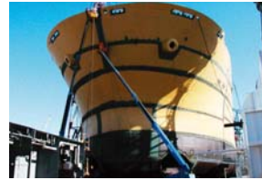
工事が進み次第に船舶らしくなっていく
