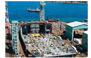
二重底部を船台に設置し、上部を組み上げていく
