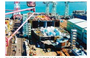
船首部が設置され、船底部が全て船台に乗った
