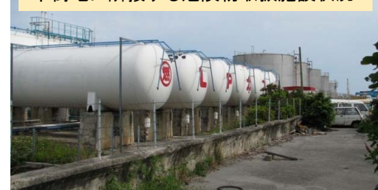
市街地に隣接する危険物取扱施設状況
