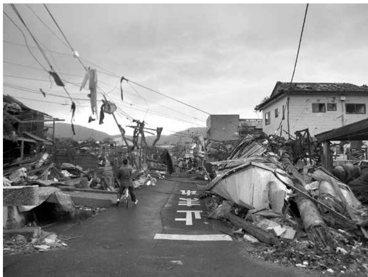
写真2 竜巻被害当日の北条の町の様子
