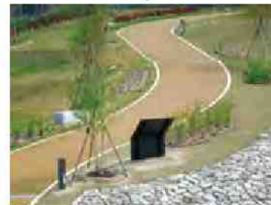
雨水貯留施設、園路、周溝の整備
