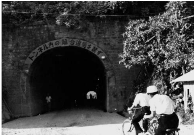
拡幅工事前の下浦トンネル
