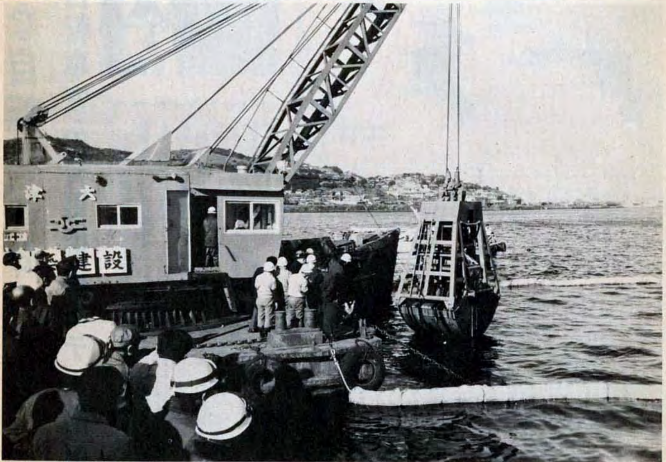
1月14日、洞海湾しゅんせつ現場
