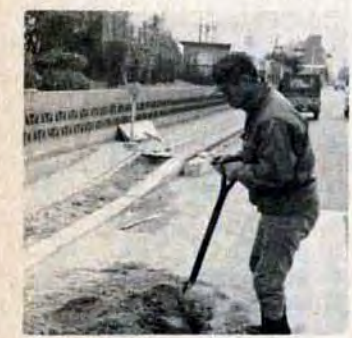
段差をなくす工事が進む歩道
