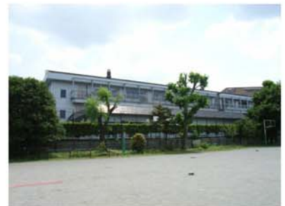
㉑敷地南側隣地の養護学校を見る
