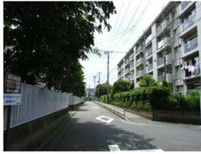
②北側道路より都営住宅を見る
