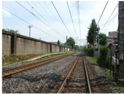
⑤西側線路より敷地を見る
