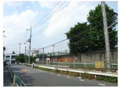
⑥西側道路より敷地を見る
