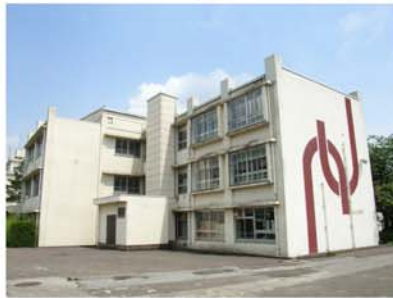
⑭敷地北西角より校舎を見る
