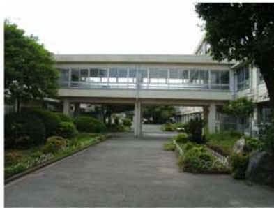
⑰校舎棟連絡ブリッジを見る
