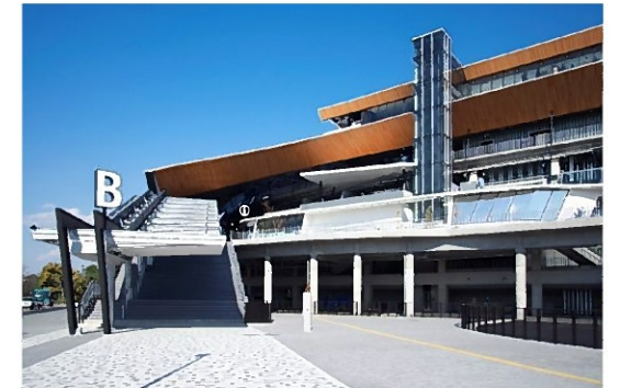
屋根が架かった幅の広いゲート
