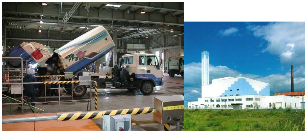
写真：北石狩衛生センター
