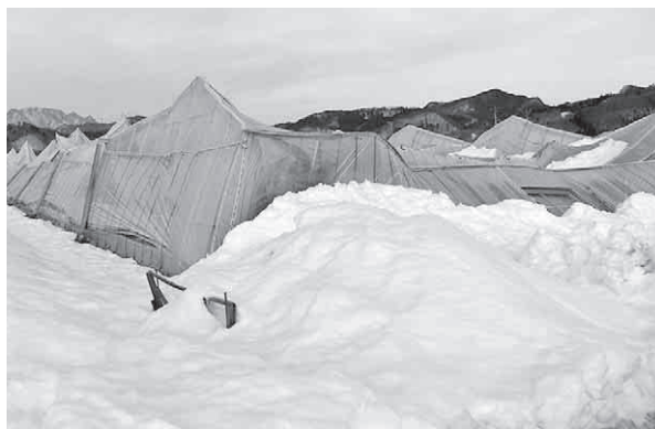
雪の重さで倒壊したビニールハウス
