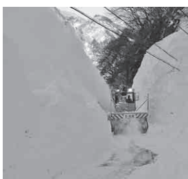
トンネルを塞いでしまった高さ10m 近い雪崩の除雪
