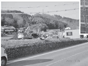
工事が進む連絡道 (国道299号線付近)
