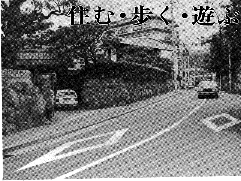
建設を待つ市道146号線図書館付近
