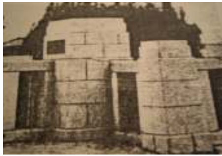
写真1 堀留橋 (千代田区, 1928. 8. 1) (復興局図面集第6巻)
