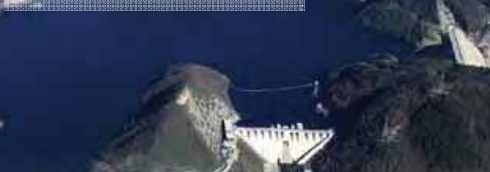
苫田ダム (岡山県鏡野町)
