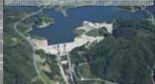
尾原ダム (島根県雲南市)
