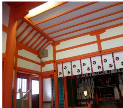
写真 4-3 山本八幡宮の拝殿と社殿の天井下地構成材
