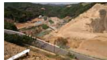
建設中の安威川ダム (手前ダム軸表示) 大門寺付近より
