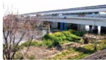
安威川鶴野橋とモノレール
