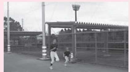
完成したブルペン上屋根と防球ネット
