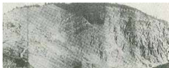
写真4-4 加奈木崩れ全景写真 (高知営林局 1967)
