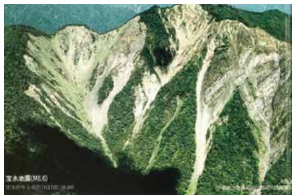
写真4-1 大谷崩れ全景写真 （富士砂防事務所 2007）
