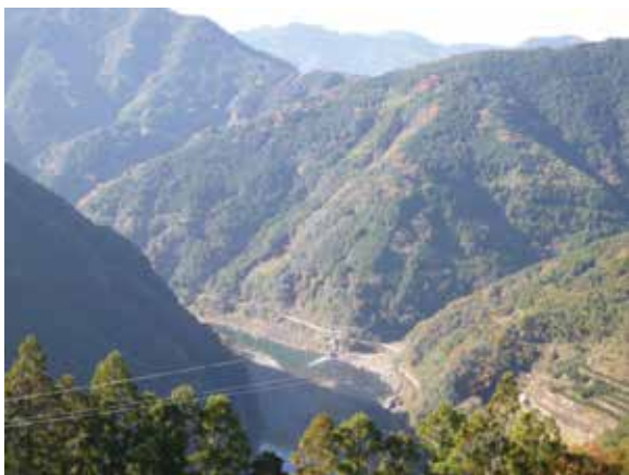
写真4-5 天然ダムを形成した仁淀川左岸の崩壊地形 (2008)
