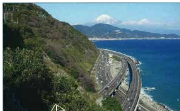
写真4-3 薩埵峠からみた富士山と由比地すべり地 (JR東海道線、国道1号線、東名高速道路) (富士砂防事務所, 2006年)
