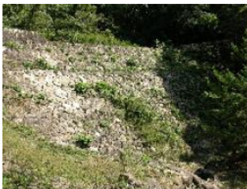
井風呂谷川砂防三号堰堤（画像：総社市公式観光 WEB サイトより）
