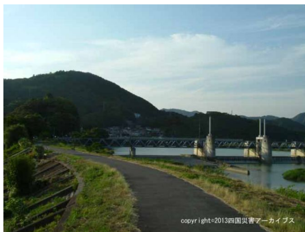
河戸堰（画像：四国災害アーカイブスより）
