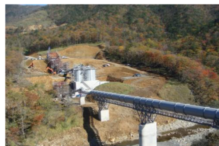
第3採石場とプラントを結ぶトンネル状のベルトコンベア
