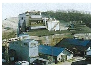
日高工場全景
