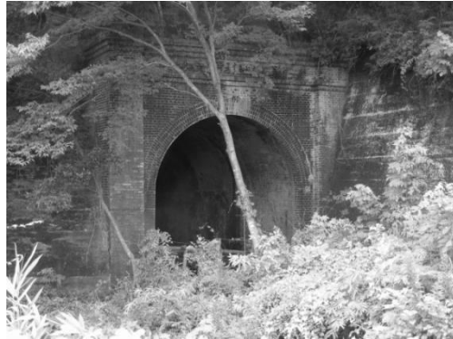
図 3 旧城山トンネル上野方坑門
