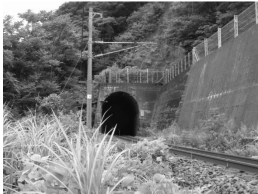
図 4 現在の城山トンネル下り線上野方坑門
