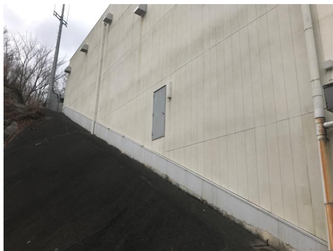
図3. センター外壁
