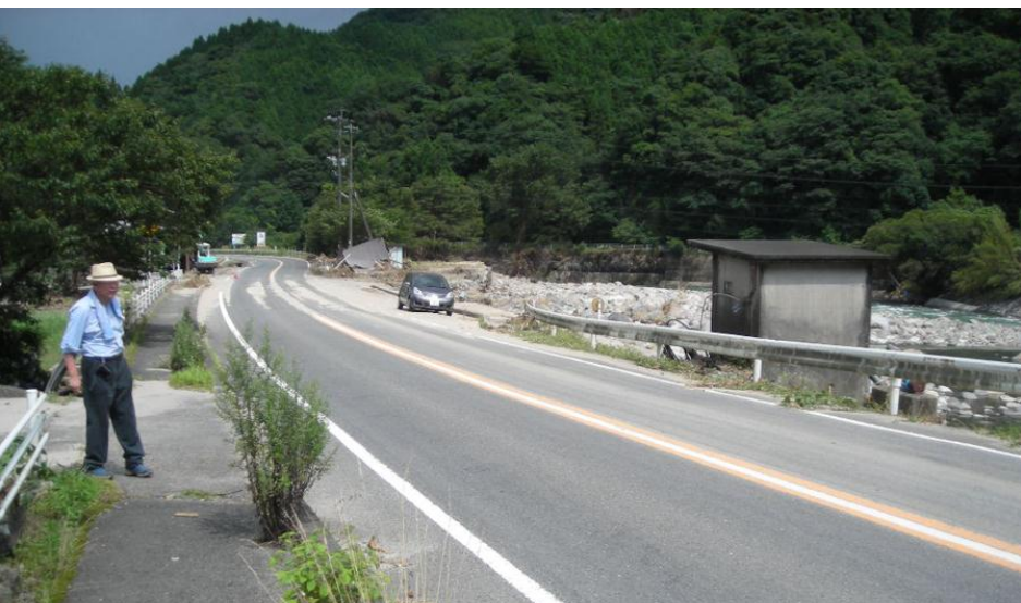
②道路が堤防の役割を果たすが、氾濫水は道路を越えて住宅地に侵入した。住宅地や道路には細粒の白砂が残された。
