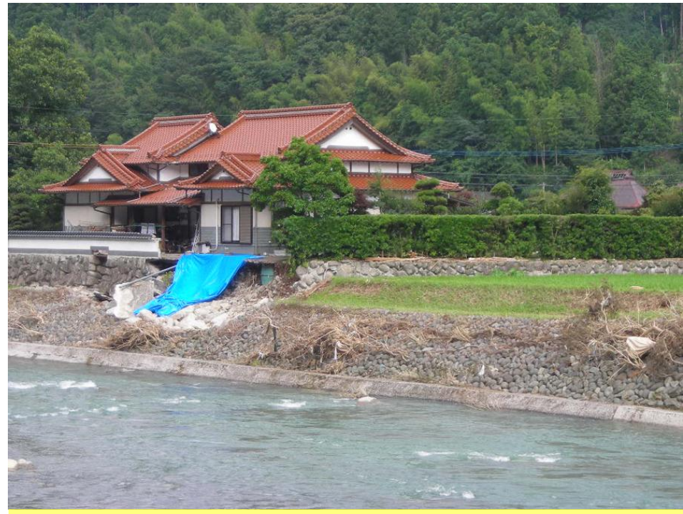
②水田と同じ後背湿地にある住宅では洗掘で壁の一部が壊れたが、1m程度の盛土により生垣と石垣の境界が洪水位となり大きな被害を免れた。
