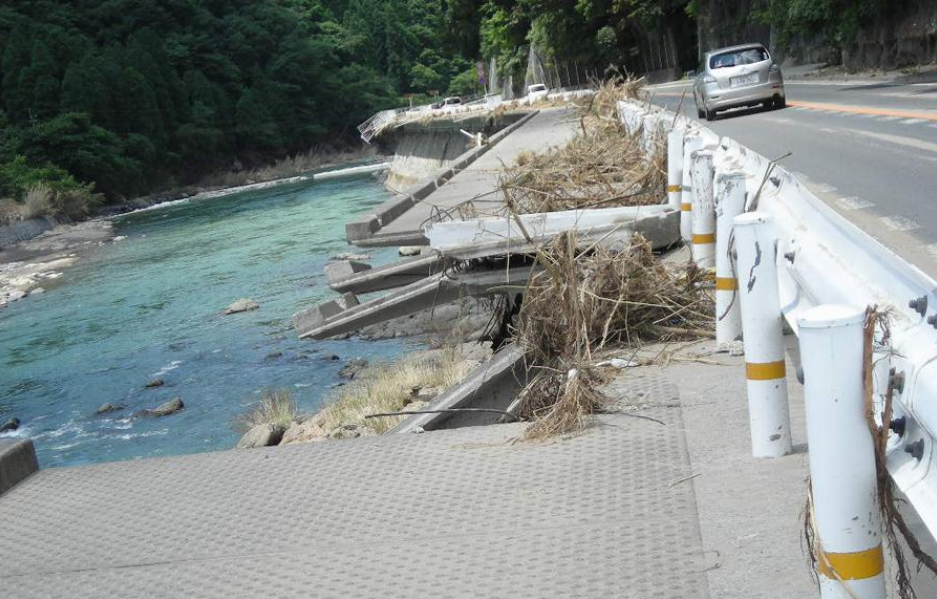
①攻撃斜面側の侵食で歩道の支えは流出し危険な状態となった。ガードレールには大量のトラッシュが残る。
