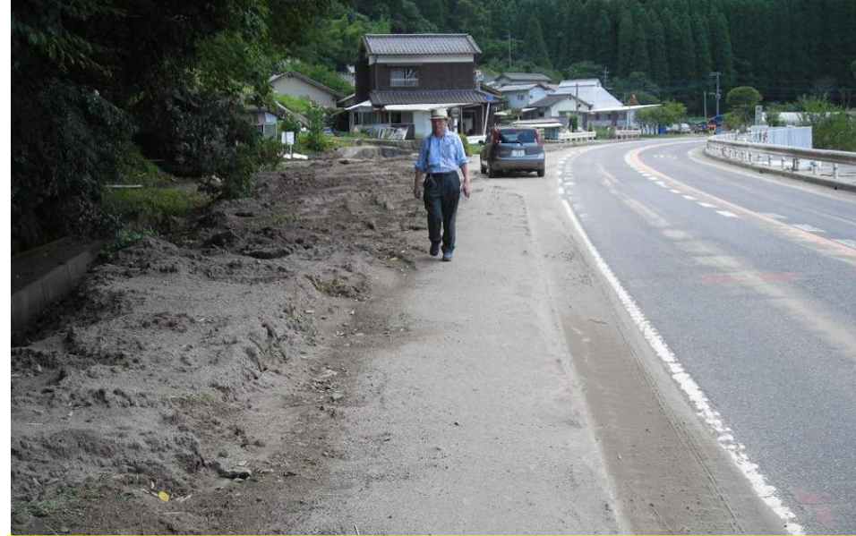
②攻撃斜面側の氾濫原にある住宅地には氾濫水が流入し大量の砂が堆積した。
