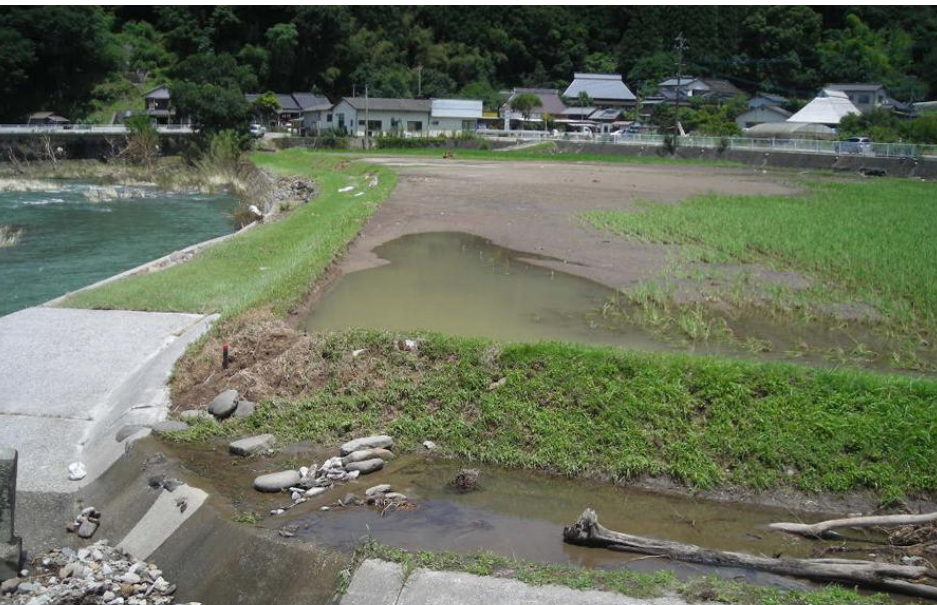
③水田に氾濫水が流入し大量の砂を残した。住宅地は水田とほぼ同じ高さである。川と水田の境に堤防はない。
