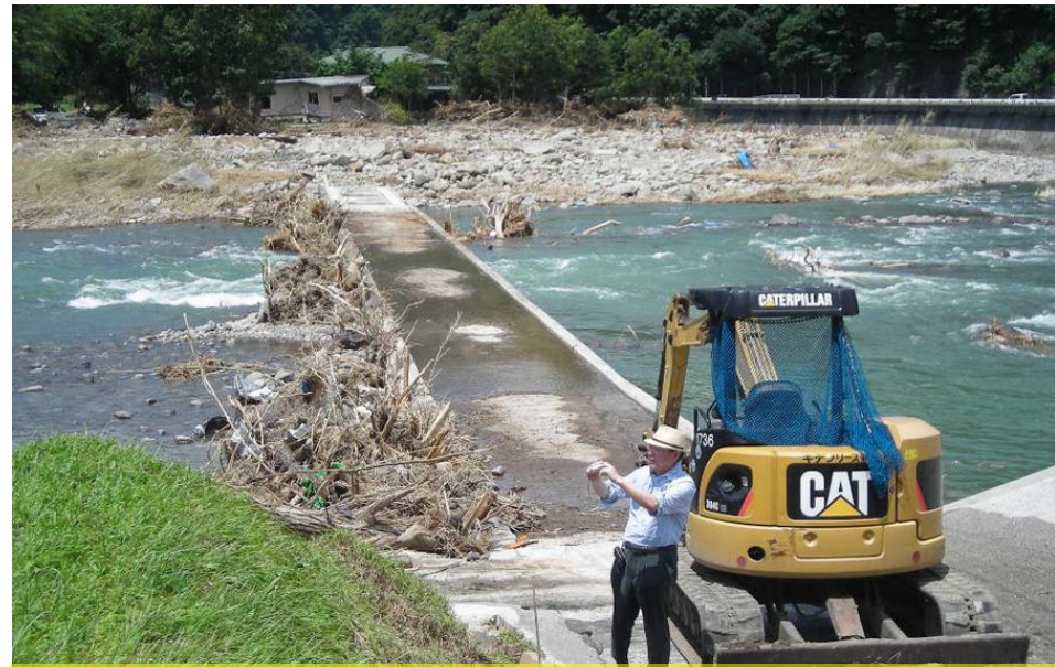
④沈下橋に多くのトラッシュが残されたが、変状は全くない。滑走斜面側では多くの大礫が堆積した。
