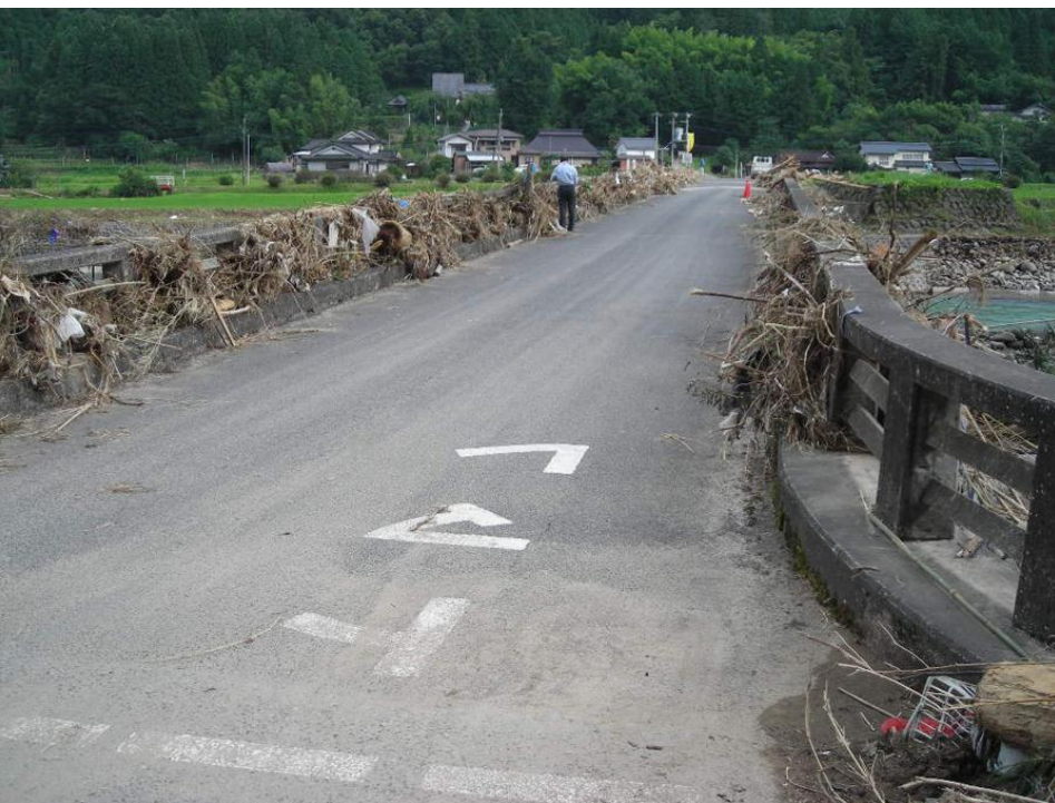
①諏訪橋の両欄干には多くのトラッシュが付着したものの流出は免れた。
