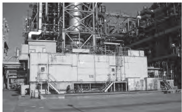
登録候補 No.6: SB60C-M 形ガスタービン(初号機) 〔新日本石油精製・川崎製油所〕
