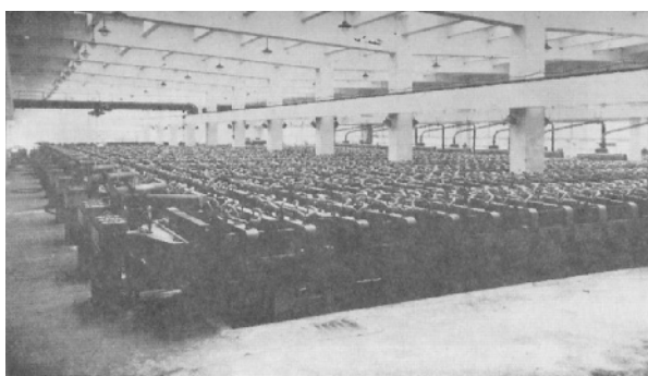
図4.5 徳曹61型水銀法電解槽
