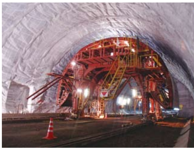
新釧勝トンネルの工事の様子
