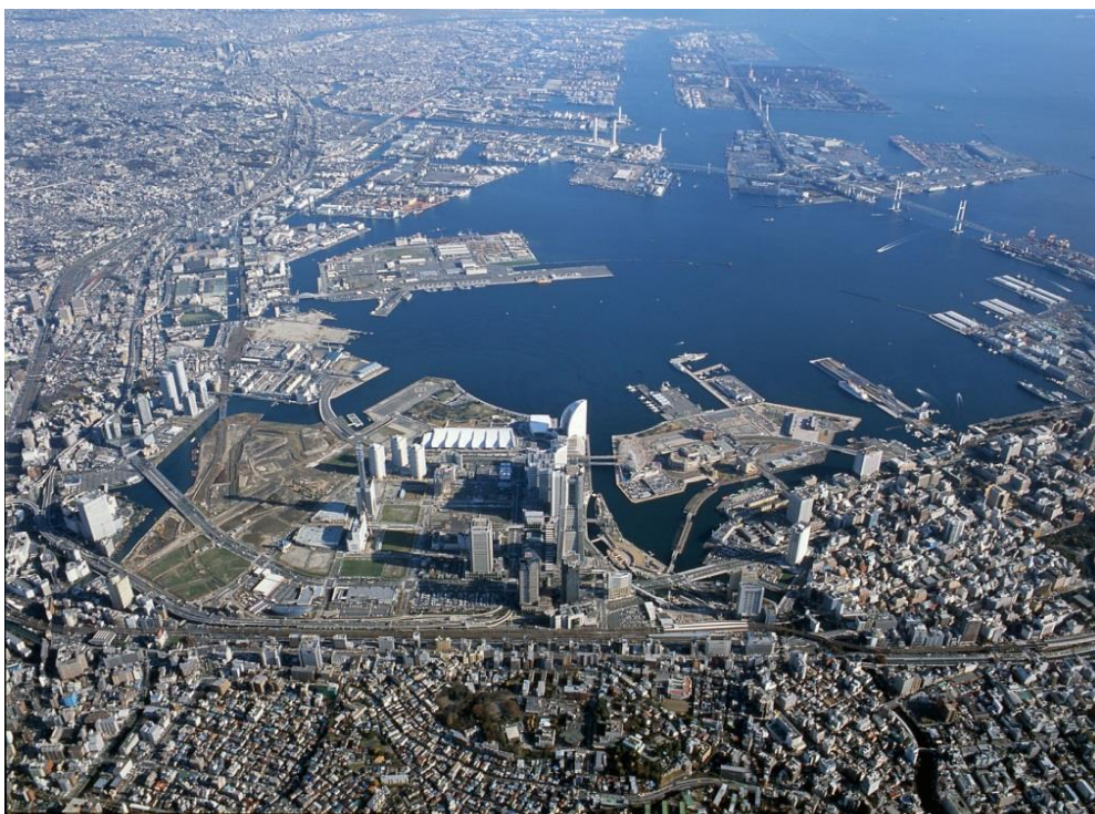
図5-14 2003年のみなとみらい21 81) インフラ整備は完了
