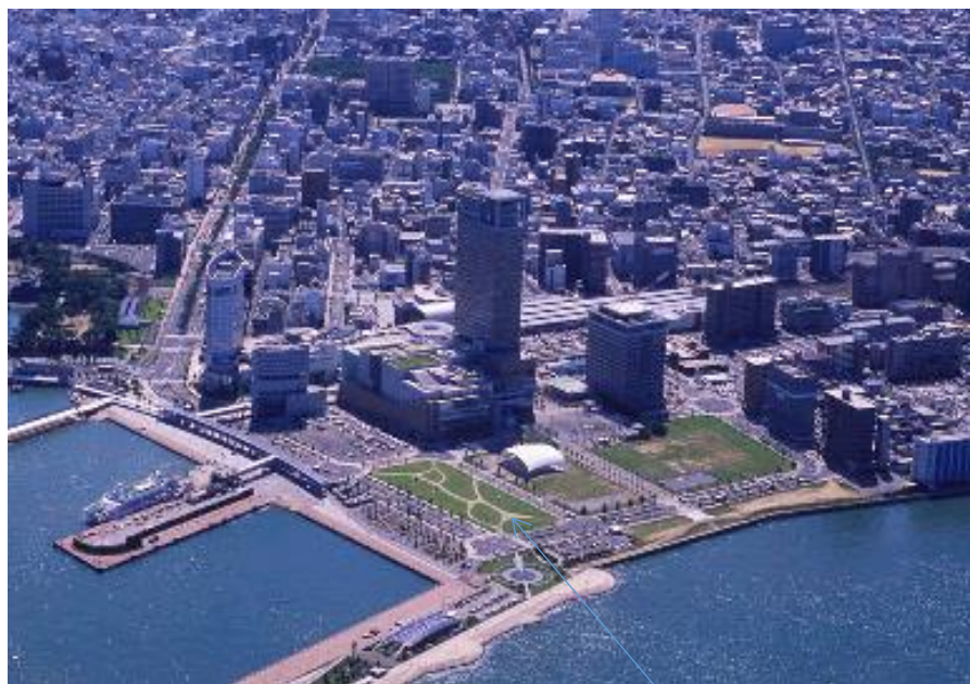
図5-19 サンポート高松の北側街区の状況 84) 北側街区
