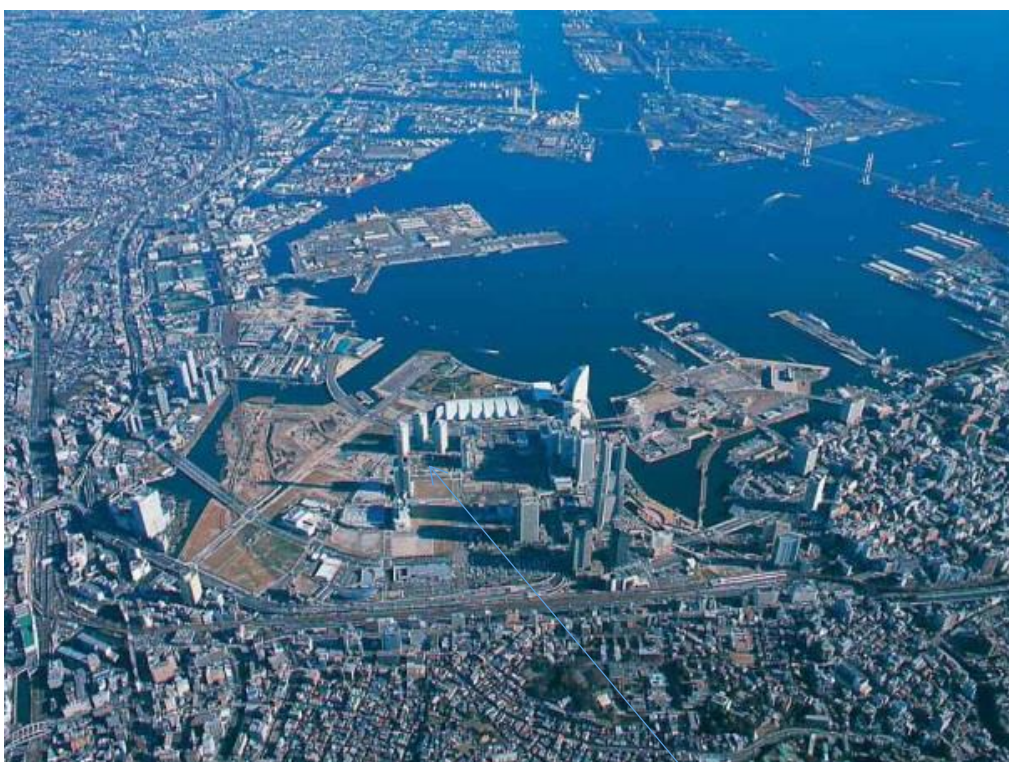
図5-15 2005年のみなとみらい21 20) 延べ面積600千㎡の高層住宅
