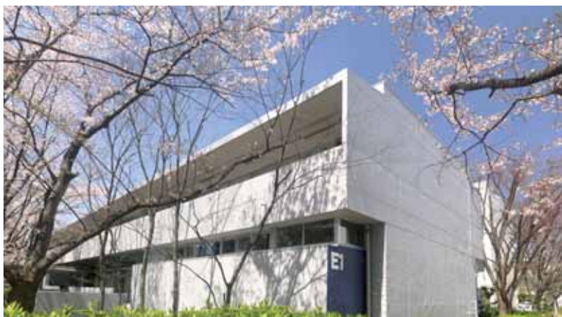
改修工事により リニューアルしたE1棟外観
