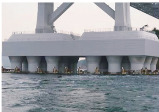
図4：多柱基礎構造で施工された大鳴門橋の橋脚部
