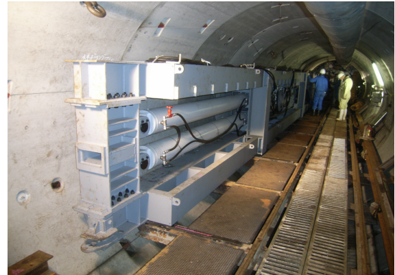
写真-10 水平ボーリングマシン据付状況 (川越側)
