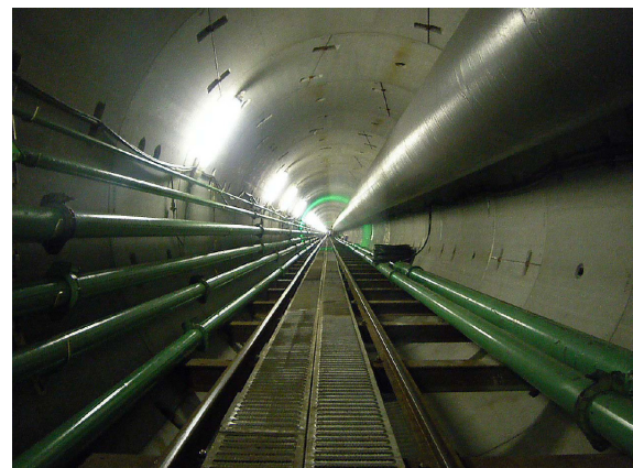
写真-9 トンネル坑内
