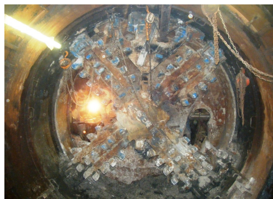
写真-12 接合時川越側シールド面 (知多側より川越側を望む)
