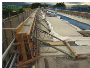
写真8 壁高欄工
