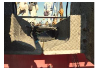
写真2 RCループ継手
