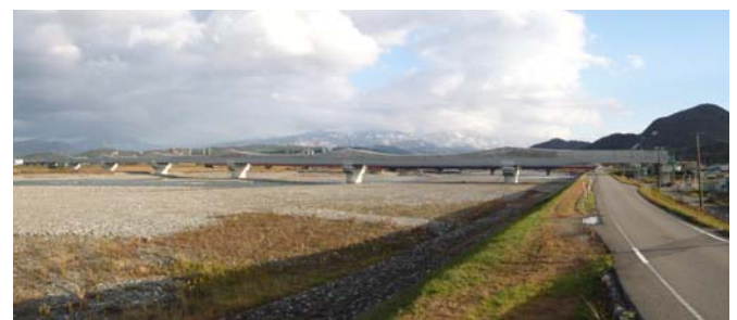
写真-2 施工完了状況 (平成19年11月現在)
