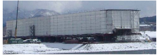
写真-1 養生仮囲い
