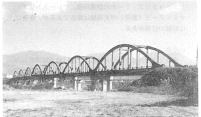
写真-10 観音橋 (1956年) 7連 (水口1998.11)
