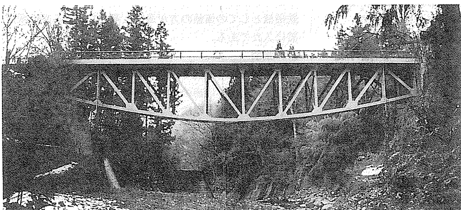
写真-2 子安橋 上路曲弦トラス(瀬川1999.12)
