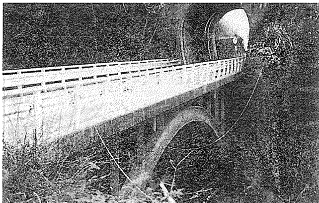
写真-14 大鹿淵橋 道路橋に改装 (水口1998.12)
