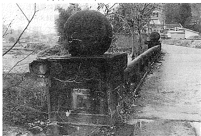
写真-7 出川橋（1950年、国道117号、飯山市）の親柱（水口1998.12）
