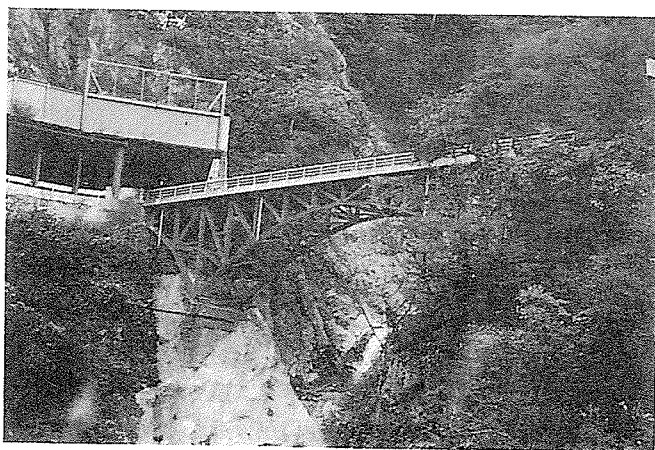
写真-5 国界橋 修理後の姿（水口1998.11）
