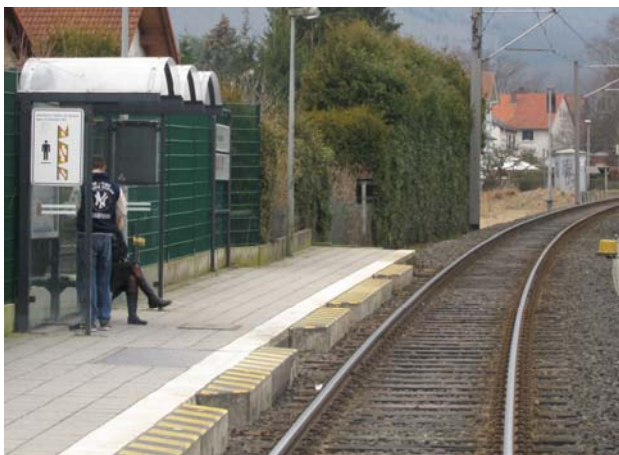
写真-3 トラム乗降のためのホーム突出 (バウナタール)
