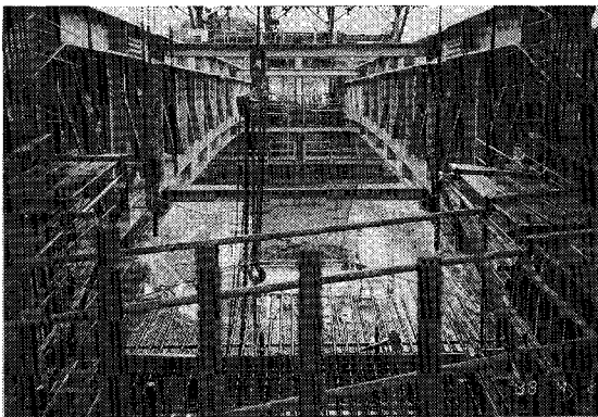
写真—2 支間中央部 70 m を閉合した状態の別府明礬橋の鋼トラス桁
