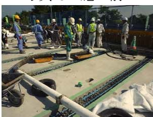
写真-7 床版連結
