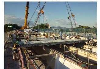
写真-6 床版架設
