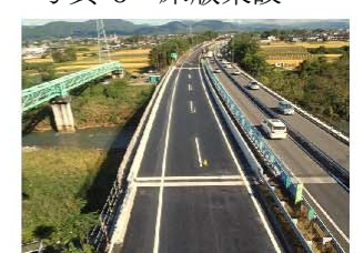
写真-10 舗装(完成)
