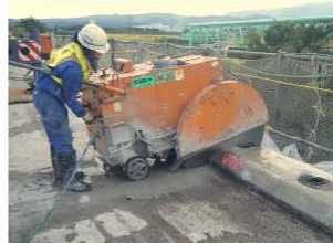
写真-4 床版切断
