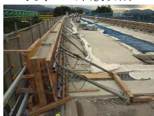
写真-8 壁高欄工
